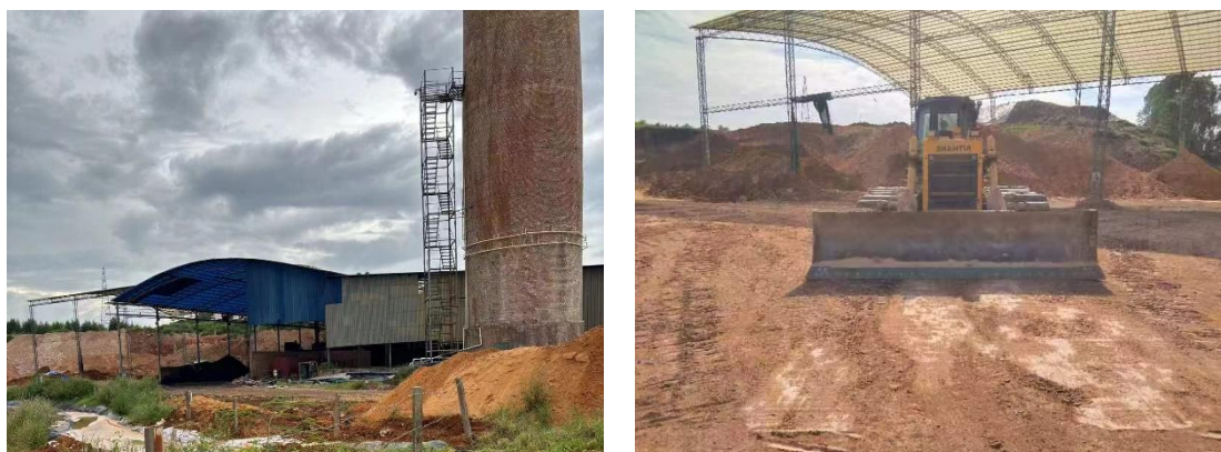
图 3-7 湛江市统盛建材有限公司现状图
