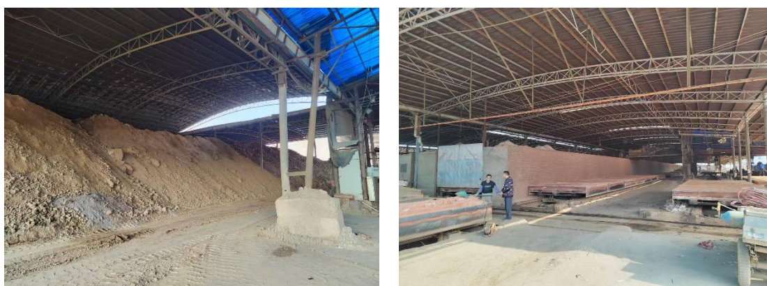
图 3-9 遂溪县黄略镇南亭建材厂现状图
