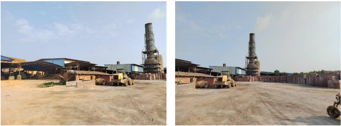
图 3-6 遂溪县遂城岭丰新型建材厂现状图
